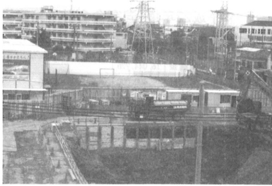
体育館棟基礎工事
