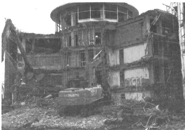
南円型校舎解体の様子（本校写真部提供）
